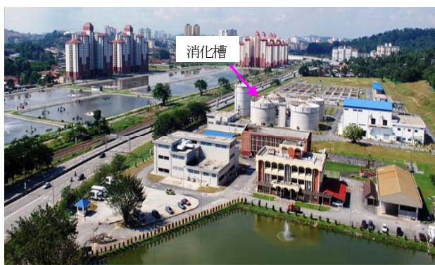
写真-1 Pantai下水処理場
