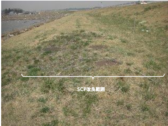
写真-4 裏小段の状況
