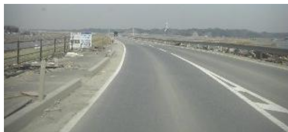
写真-2 天端の状況
