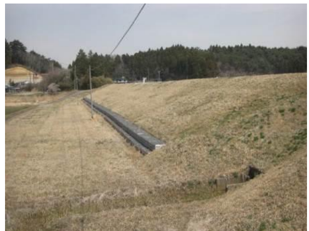
写真-10 ドレーン工設置状況
