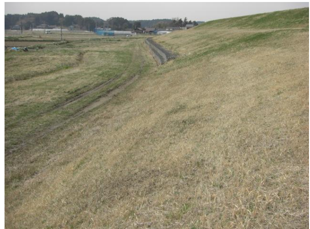
写真-6 対策区間 (写真奥のり尻にドレーンが設置されている区間)
