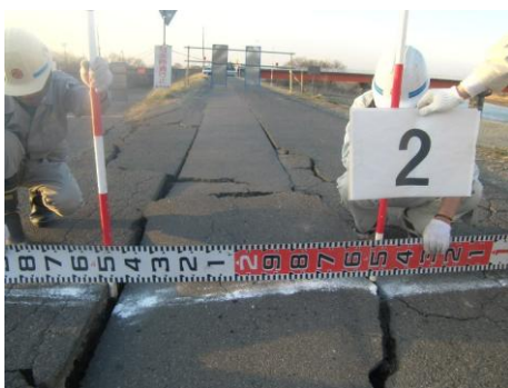
(b) 天端付近の状況
