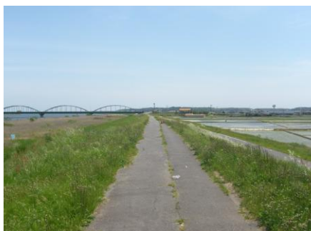
写真-1 液状化対策実施箇所の状況 (利根川右岸 27.75k-51m~28.0k-1m) 1)
