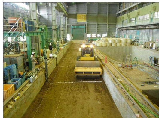
写真-5 転圧試験状況
