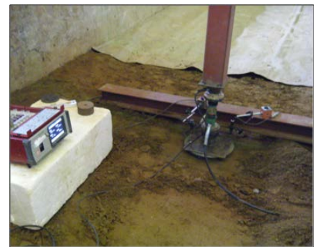
写真-9 平板載荷試験状況
