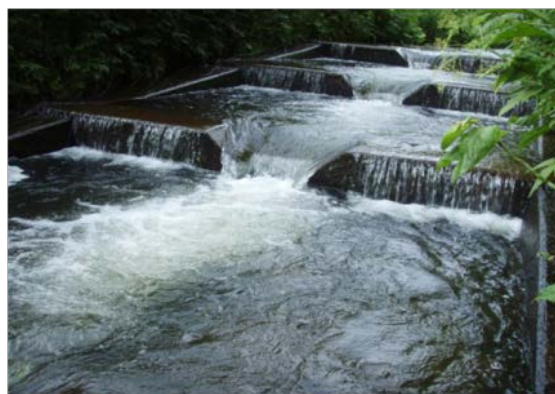
写真-1 魚道周辺の河岸状況
