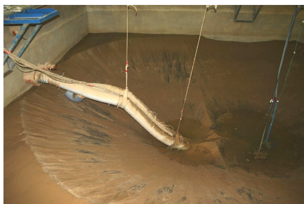
図-5 ケース2の排砂後の状況
