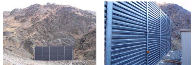
写真-1 対象斜面と仮設防護柵
