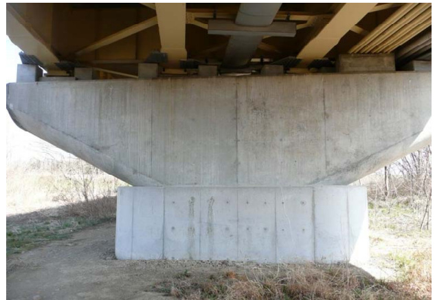
(b) 耐震補強されていた橋脚の状況
