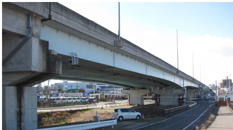
図-6 亀田大橋の全景写真
