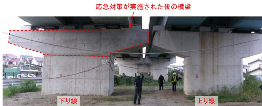
(b) 応急復旧後の状況
