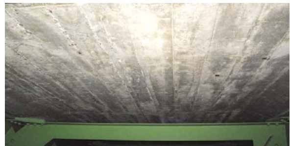
写真-1 撤去前の RC 床版下面の状況
