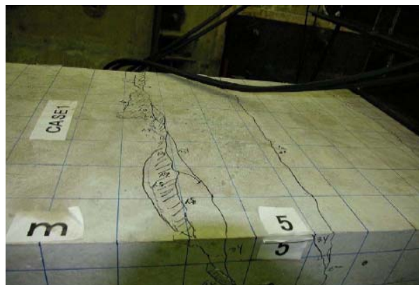
写真-4 CASE1の損傷写真 (頂版左部 層間変形角 6/300)
