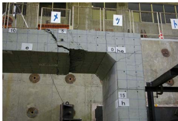
(b) せん断破壊箇所
