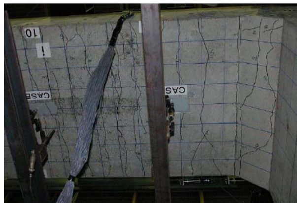
写真-7 CASE2 の損傷写真 (頂版右端部 層間変形角 4/300)
