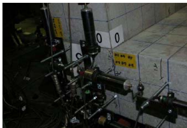
写真-2 CASE1の損傷写真 (側壁基部 層間変形角 1/300)
