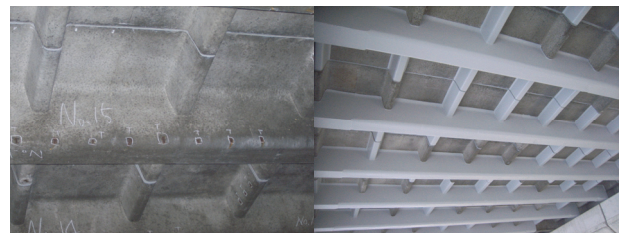
写真-13 PC製落石覆道頂版部の繊維混入塗装による対策例
