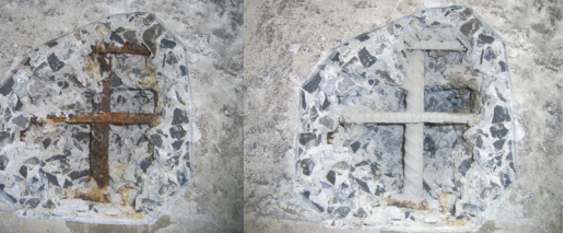
写真-14 柱部の補修・補強の状況例
