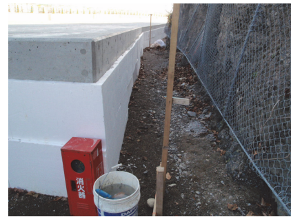
写真-12 三層緩衝構造による覆道補強対策
