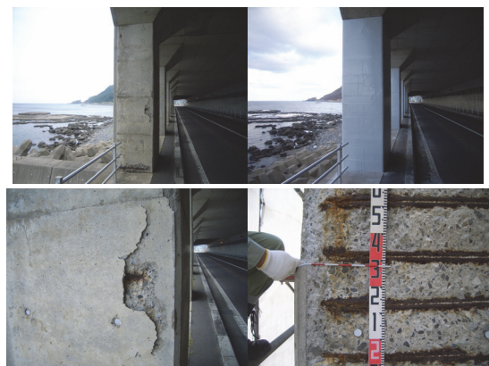
写真-13 PC製落石覆道頂版部の繊維混入塗装による対策例
