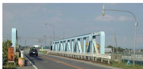
写真-1 調査対象橋梁
