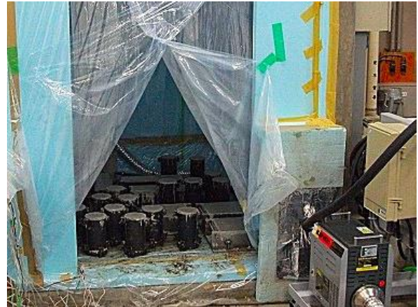
写真-1 蒸気養生状況
