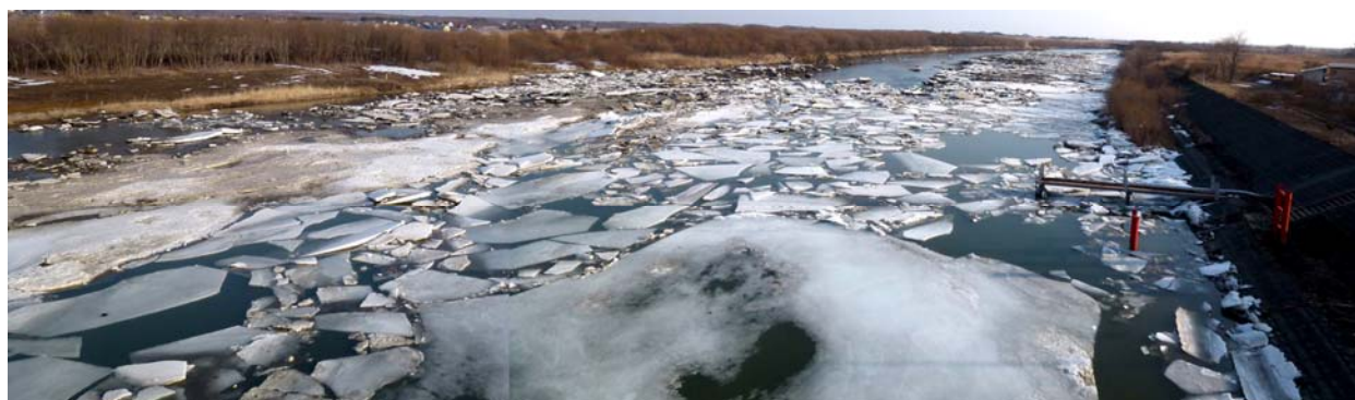
写真 - 3.5 鵜川において津波遡上に誘発されたと考えられるアイスジャムの概況
