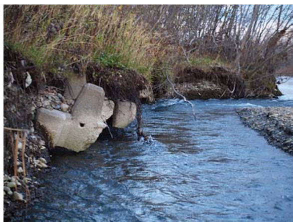
写真-4 石狩川上流における護岸根固工
