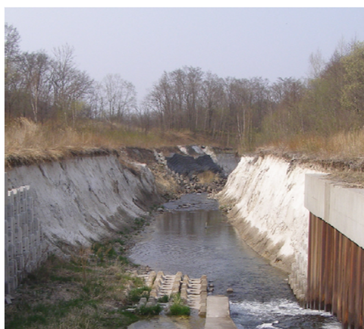
写真-3 渋山川における土丹河床の函状浸食
