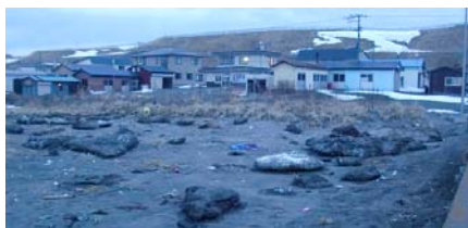
図-2 東北地方太平洋沖地震で発生した津波により遡上した流氷跡 (根室半島太平洋沿岸部)
