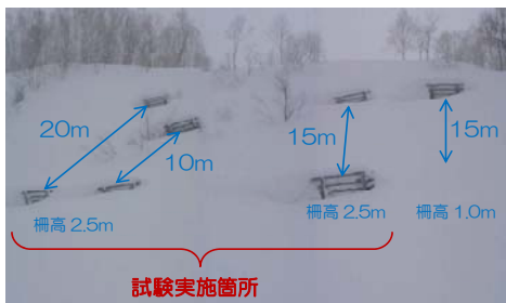
図 3 試験斜面の状況
