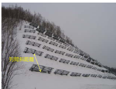
図 1 雪崩予防柵(吊柵)の設置状況の例
