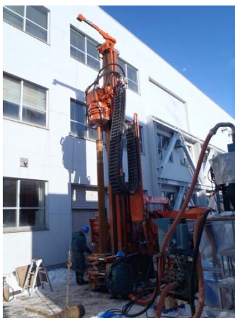
写真-4 採熱孔掘削（ソニックドリル）
