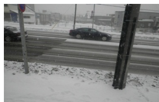
写真 1 ロードヒーティングの融雪状況
