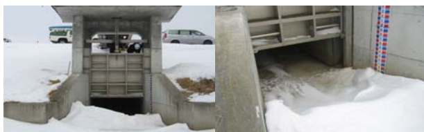
写真-13 ローラーゲート冬期状況
