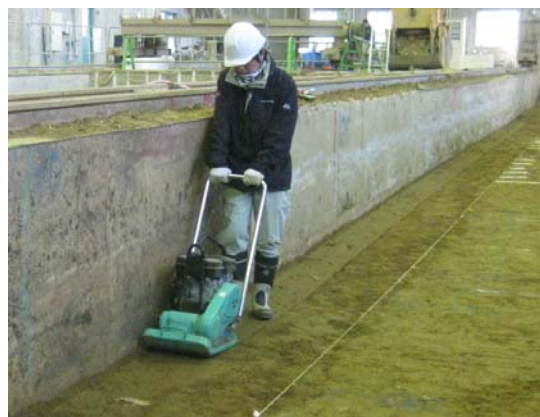
写真-6 締固め回数試験状況
