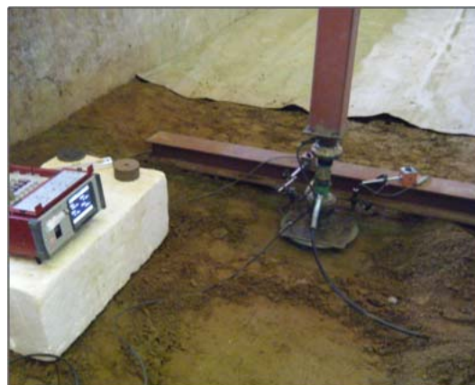
写真 - 10 平板載荷試験状況
