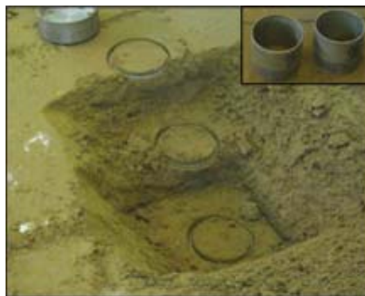
写真-7 コアサンプリング状況
