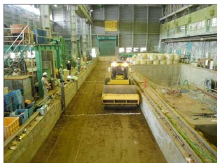
写真-4 転圧試験状況
