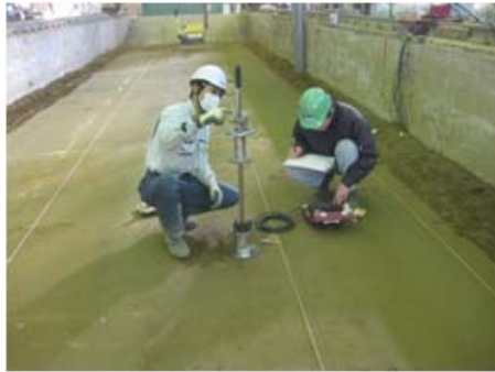
写真-7 小型FWD試験状況
