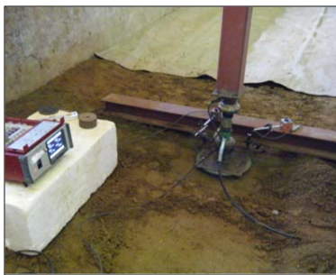
写真-8 平板载荷試験状況
