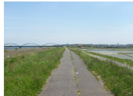
写真-3.1 液状化対策実施箇所の状況（利根川右岸 27.75k-51m～28.0k-1m） 2)
