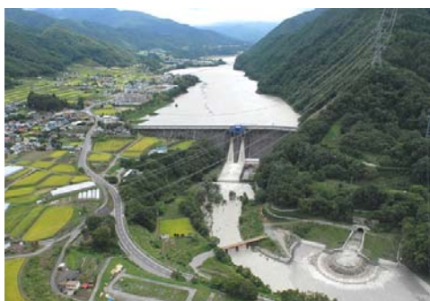
写真 1. 土砂バイパスから放流される濁水 (三峰川総合開発事務所パンフレットより抜粋)
