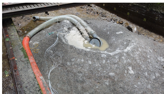
図-11 排砂・排水後の状況 (右岸側下流から、2012年7月)
