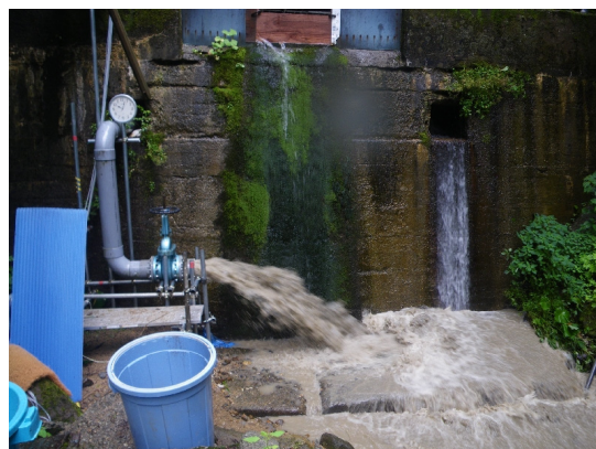
図-10 排砂中の堰堤下流の状況 (2012年7月)
