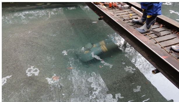
図-23 折返し部の浮き上がり (2012年11月)
