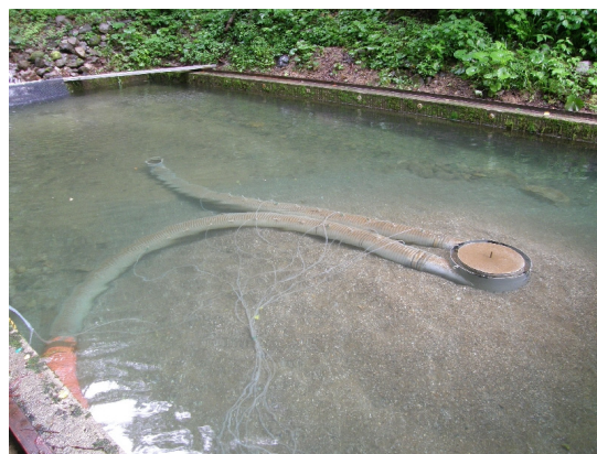
図-9 排砂前の状況 (右岸側下流から、2012年7月)
