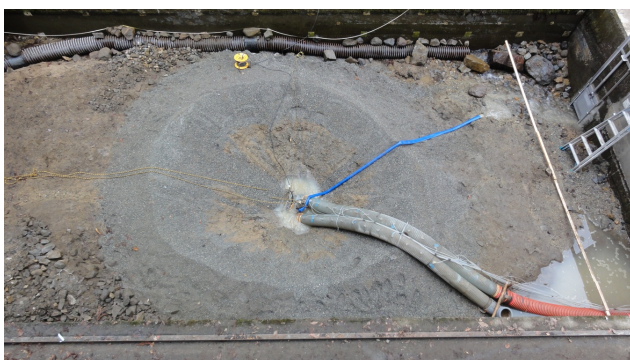
図-13 排砂・排水後の状況（上方から、2012年11月）
