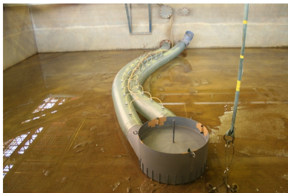
a) 排砂管上流側から撮影
