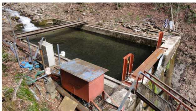
図-3 ヒル谷試験堰堤（右岸側下流上方から撮影）
