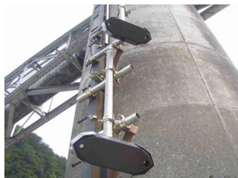
図-18 音響測深機の設置状況②
