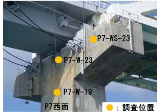
写真-5 P7 橋脚梁部(西面)
