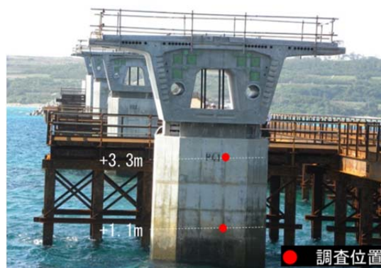
写真-11 伊良部大橋 P41 橋脚
