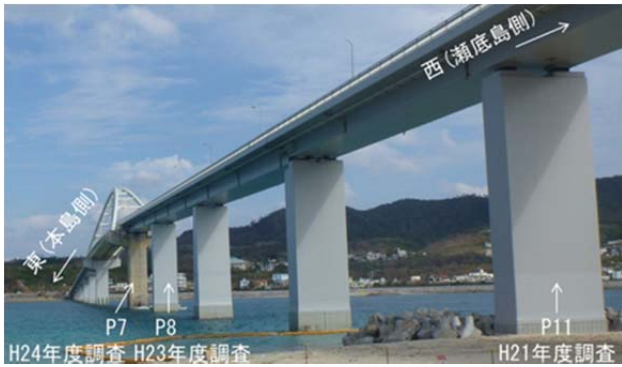
写真-1 瀬底大橋（瀬底島より）
