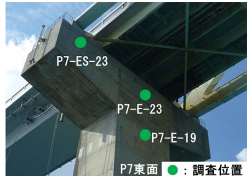
写真-6 P7 橋脚梁部(東面)
