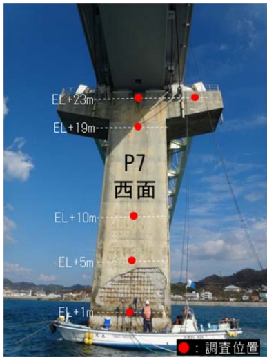
写真-2 P7橋脚（瀬底島側より）
