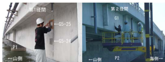
写真-10 拭取り調査状況(左:第1径間、右:第2径間)
