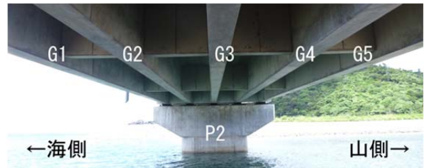
写真-9 結橋 桁下状況(A2側から7月時)
