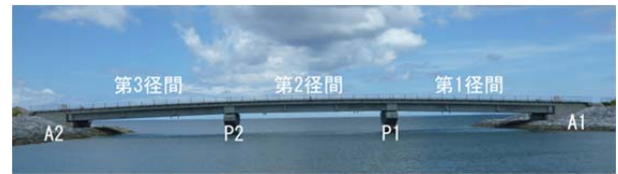
写真-7 結橋 全景(山側から7月時)
