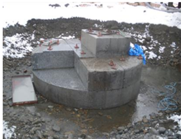
写真-4 RC橋脚の撤去状況
