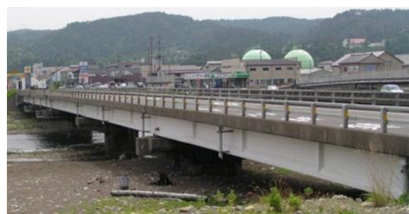
写真-1 対象橋梁の全景
