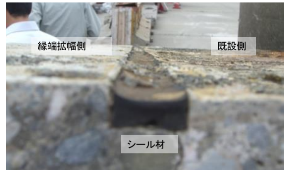
写真-5 縁端拡幅部と既設部と境界部上面に設置されたシール
