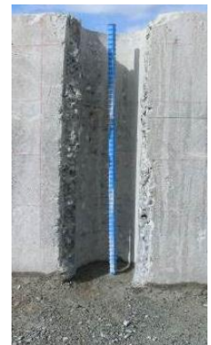
写真-13 RC巻立て軸方向鉄筋のハツリ出し状況
