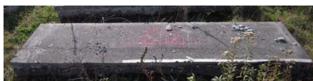
写真-2 撤去床版の一例 (パネル No. 2-14)
