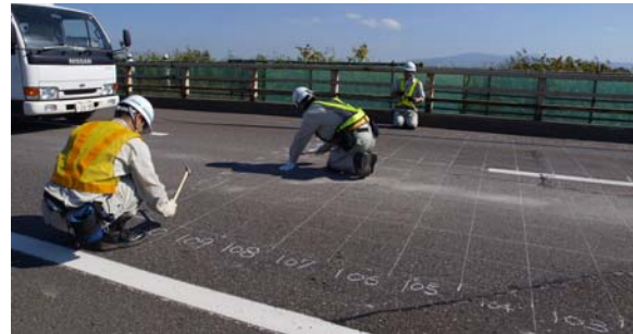
写真-1 現地調査の様子 (舗装上面からの打音)
