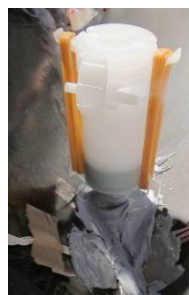
(b) 座金に低圧注入器具を取付
