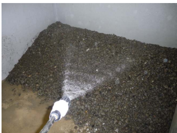
写真-2 表面塩分除去作業状況
