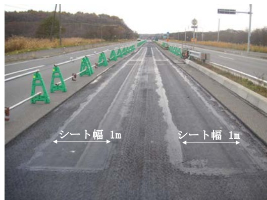
写真-4 ひび割れ抑制シート貼り付け後の状況
