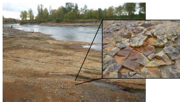
図-12 乾湿繰返しにより表層が劣化した岩と河床の侵食状況(石狩川)
