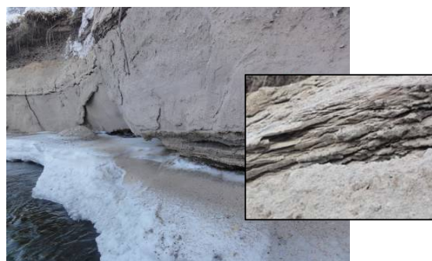
図-11 凍結融解による表層が劣化した岩と河岸の侵食状況(久著呂川)
