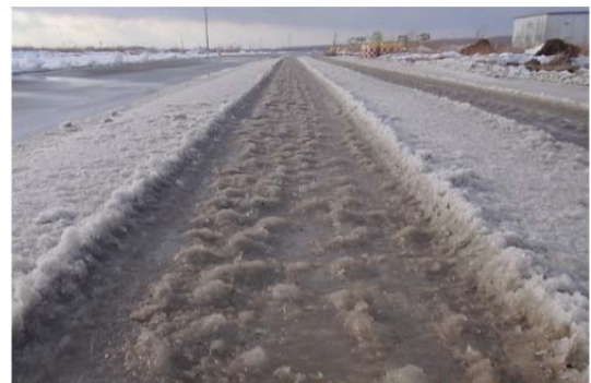
写真-4 ダンプ走行350台通過後の路面状況
