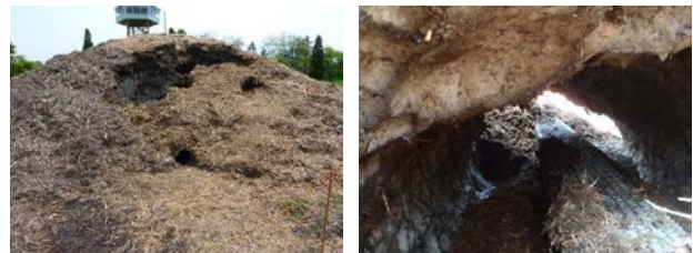
写真-8 全空気式 (6/5) 雪山状況
