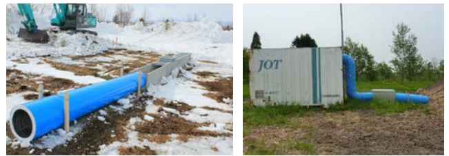
写真-3 トラフ設置 写真-4 実験庫ダクト接続
