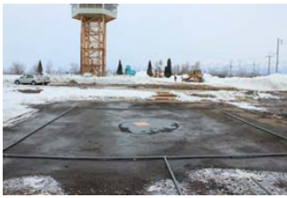
写真-5 塩ビ管設置
