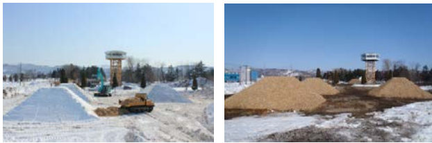
写真-2 雪山造成(左:バーク材被覆前、右:被覆後)
