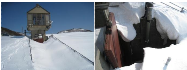
写真-6 スライドゲート冬期状況 (道北地区 留萌)
