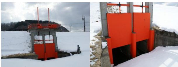
写真-5 スライドゲート冬期状況 (道南地区)
