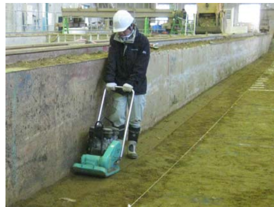
写真-6 締固め回数試験状況
