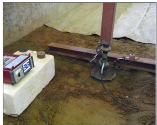
写真-10 平板載荷試験状況
