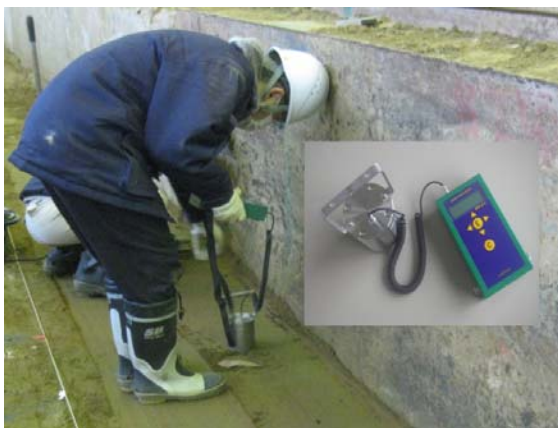
写真-8 超小型動的平板載荷試験状況
