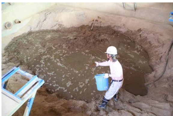
図-48 流木模型投入状況
