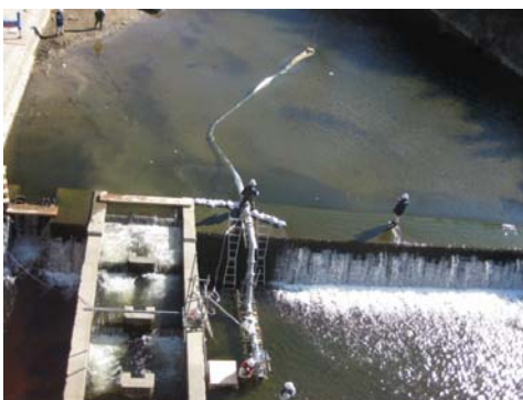
図-9 潜行吸引式排砂管設置状況(11/19)
