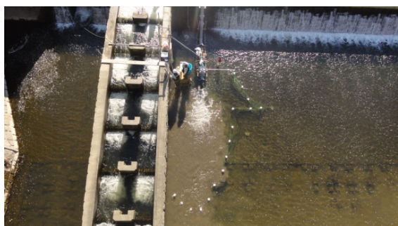
図-36 試験実施中の排出口付近の状況 (11/22 9:37)
