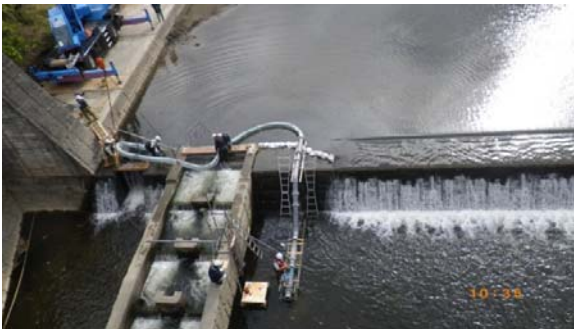
図-7 潜行吸引式排砂管設置状況(11/19)
