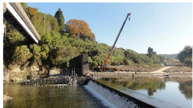
図-10 日竹貯砂ダム(試験時に左岸側から撮影)
