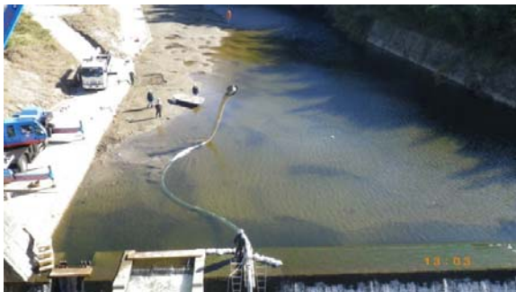
図-8 潜行吸引式排砂管設置状況(11/19)
