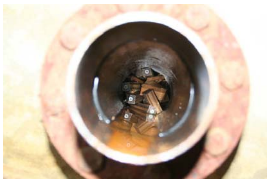
図-51 バタフライバルブ設置位置の流木模型の閉塞状況
