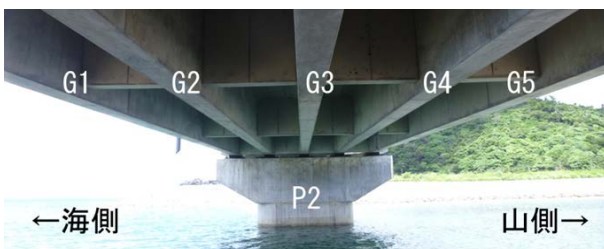
(b) 第3径間桁下面状況 (A2側から)
