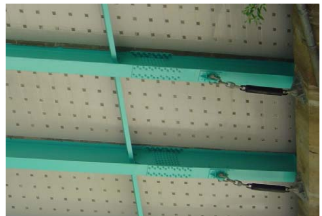
写真-1 シート接着補強（格子貼り）された RC 床版の事例
