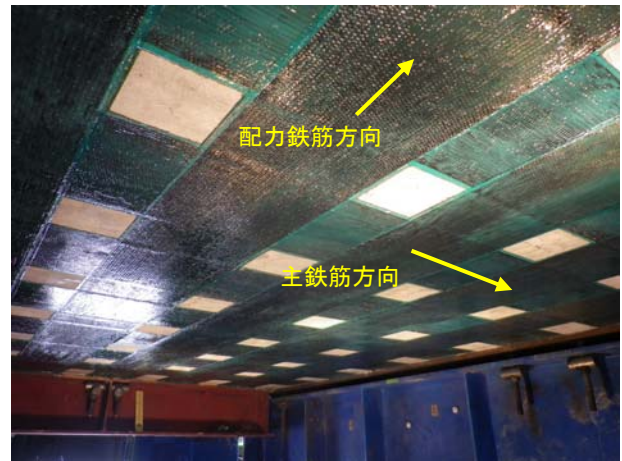
写真-2 供試体CF2のシート接着補強の施工完了時の状況
