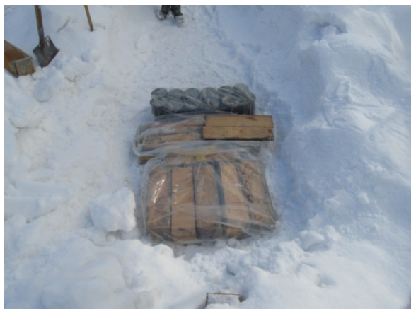
写真-1 雪中養生の状況 (養生中は雪で覆う)
