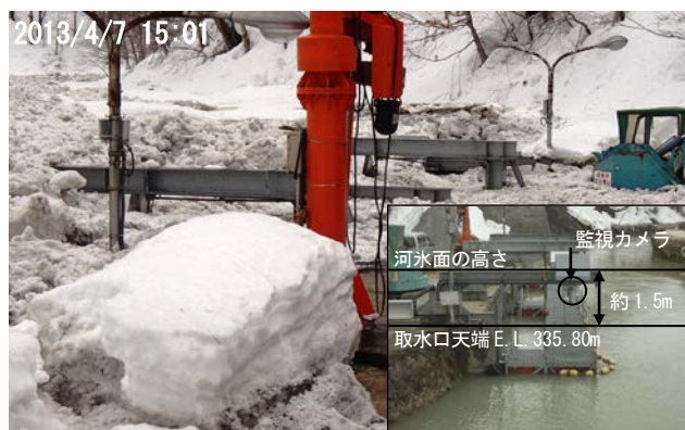
図-4 取水口の状況 2013/4/7 ダム管理支所撮影
