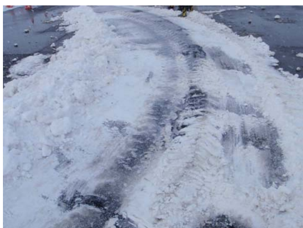
図-11 残雪の発生状況（除雪ドーザ）
