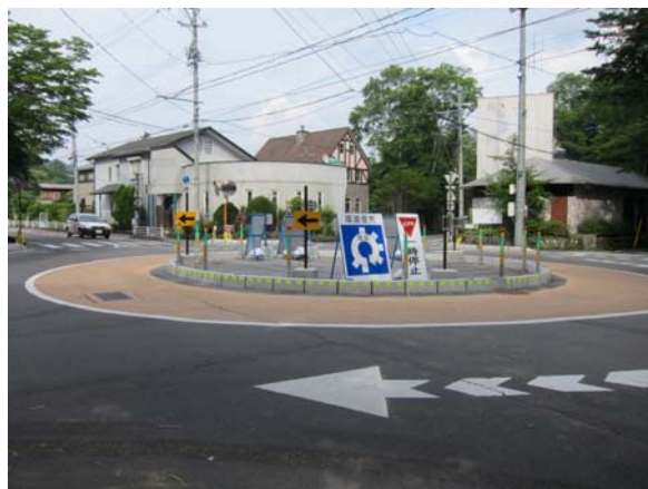
図-18 社会実験中のラウンドアバウト (長野県軽井沢町、平成25年7月)
