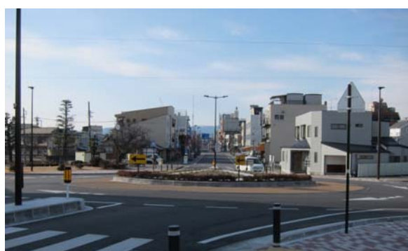
図-19 新設された環道1車線型ラウンドアバウト (長野県飯田市、平成26年1月)
