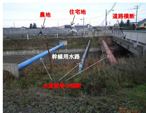
写真-1 大規模地震時に想定される重大な被害が想定される現地状況の事例
