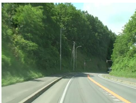
写真-15 迫ってくるカーブと切土法面
