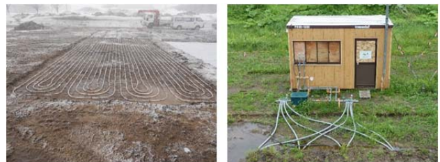
写真-2 採熱管布設（左）、計測室（右）
