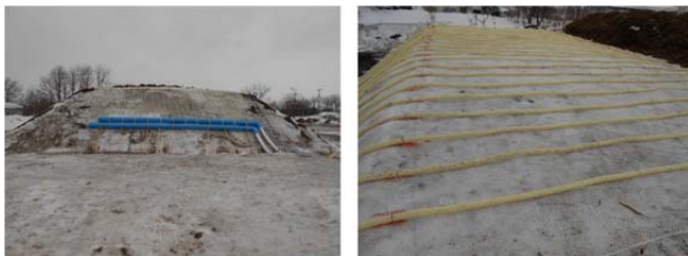
写真-5 採熱管布設法面 (左)、天端 (右)
