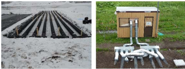
写真-4 採熱管布設 (左)、計測室 (右)
