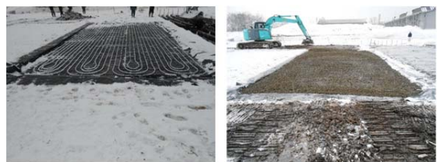
写真-3 採熱管布設（左）、埋戻し（右）
