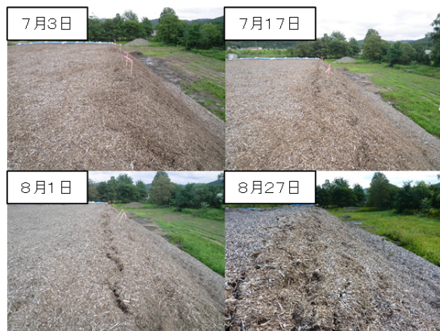
写真-8 断熱材亀裂状況
