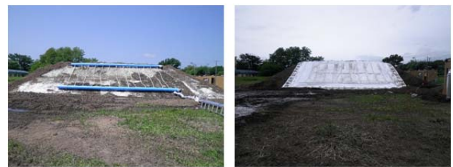
写真-6 採熱管布設 (左)、シート布設 (右)
