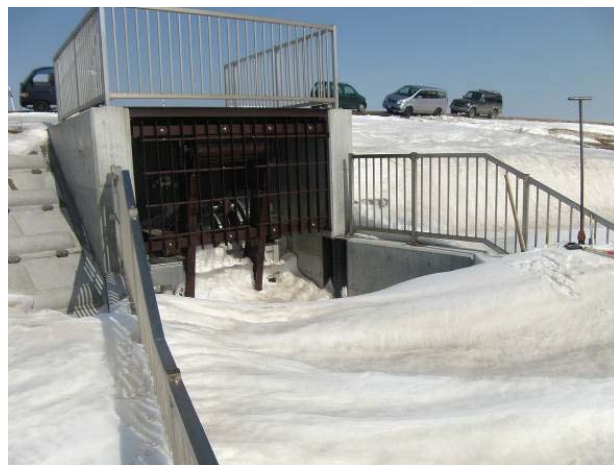
写真-14 十勝太東5線樋門 扉体付近状況
