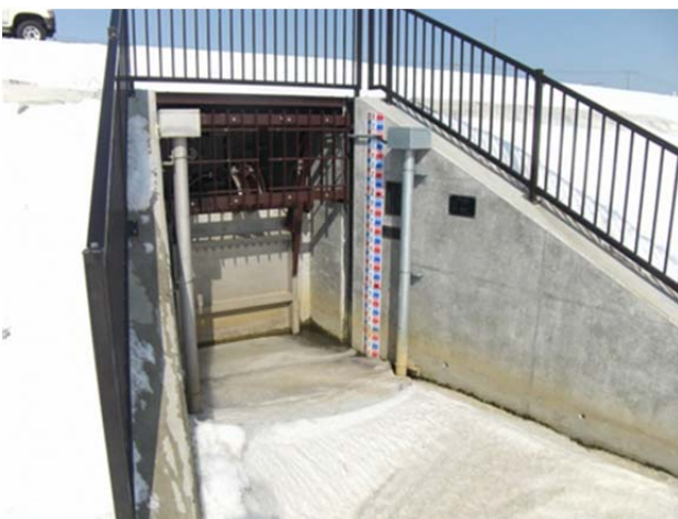
写真-13 十勝太樋門 扉体付近状況
