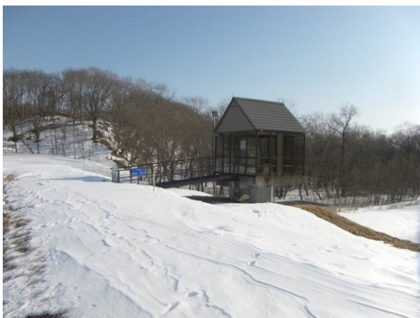
写真-8 静内川第1樋門 堤防積雪状況(17cm)
