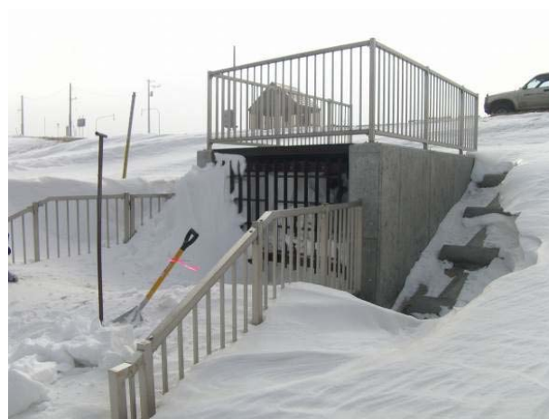
写真-15 豊北第1樋門 扉体付近状況
