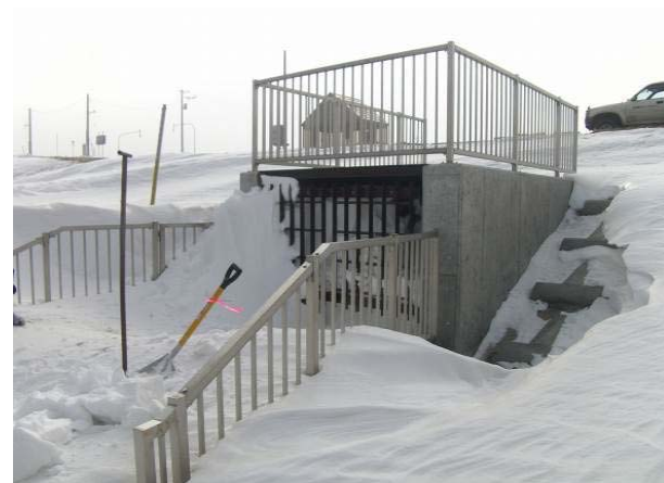
図-33 門柱レスゲート扉体付近状況③
