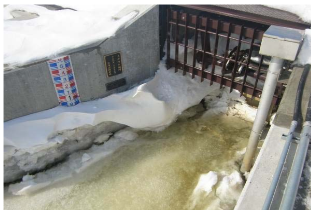
図-28 門柱レスゲート 積雪状況
