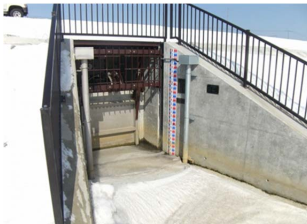
図-31 門柱レスゲート扉体付近状況①
