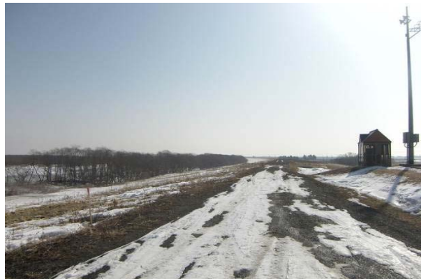
図-27 堤防積雪状況
