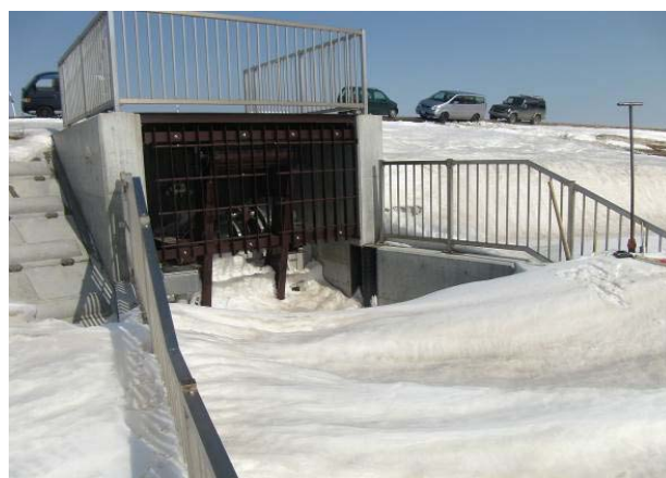
図-32 門柱レスゲート扉体付近状況②
