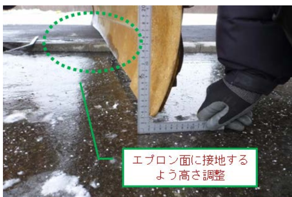
図 7 ブレードの接地状況 (モータグレーダ)
