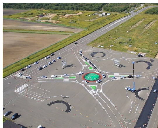
写真1 試験設置したラウンドアバウトの外観
