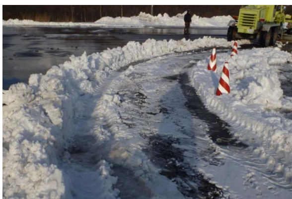
写真 7 残雪の発生状況 (モータグレーダ)
