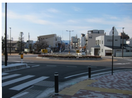
写真16 ラウンドアバウト (長野県飯田市東和町)
