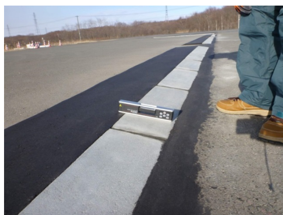
写真3 すりつけ形状の模擬エプロン (傾斜角度 11°)
