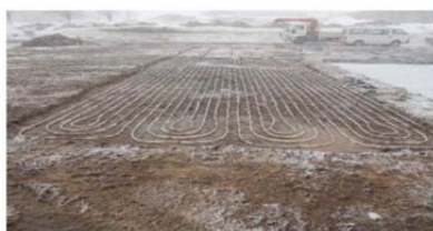
写真-2 H25 実験 A 配管敷設
