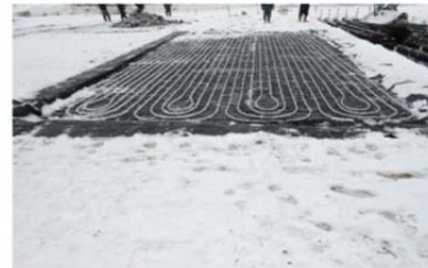
写真-3 H25 実験 B 配管敷設
