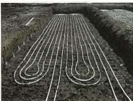
配管敷設 (雪山下面-600mm)
