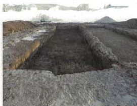
採熱箇所掘削状況
