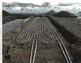
配管敷設 (雪山下面-300mm)
