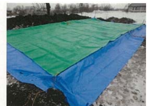
ポリエチレンシート敷設 (更にこの上にバーク材被覆)
