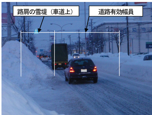
写真1 道路有効幅員と路肩の雪堤
