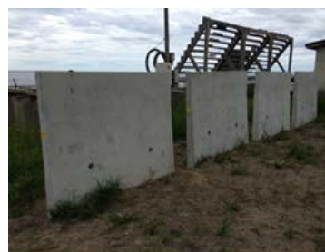
写真-1 L型擁壁設置状況
